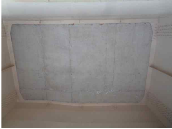
바닥판 하면 S1 상태 양호
