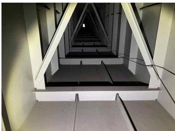
거더내부 상태 양호
