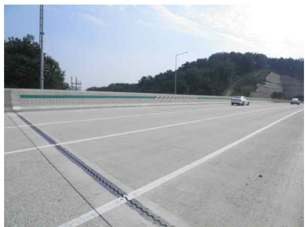
중앙분리대 상태 양호
