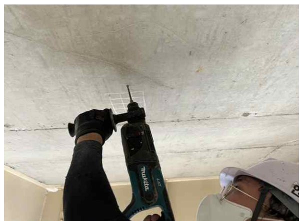
탄산화깊이 측정 현황
