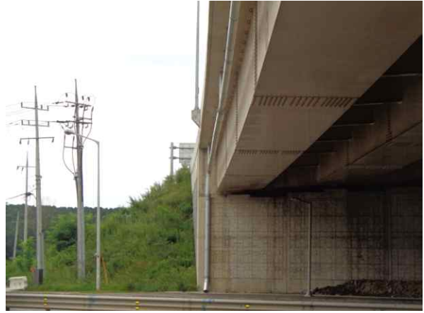
배수관 상태 양호
